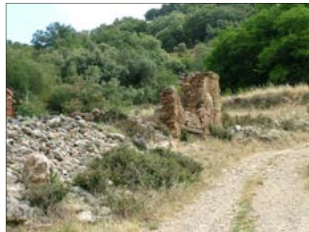
Figura 17. Altro esempio di costruzione abbandonata in un'epoca recente. La fotografia è stata scattata a La Balouta (Leon, Spagna).
