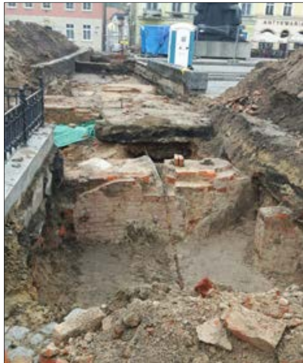
Figura 24. Antica piazza del mercato a Bydgoszcz (Stary Rynek), Polonia, durante lavori di manutenzione.
